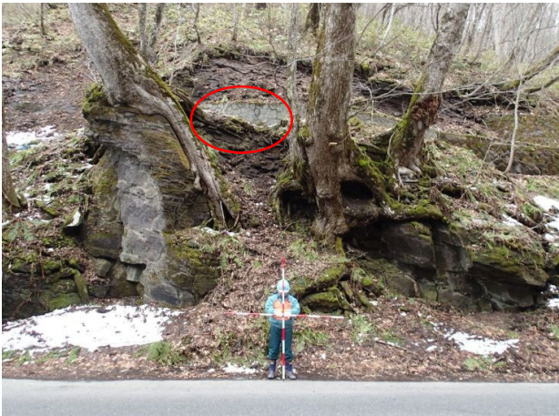
(1/3) 36.135kp付近:道路面から高さ≒6m付近に不安定化した転石(φ30×20 cm程度)が認められる。
