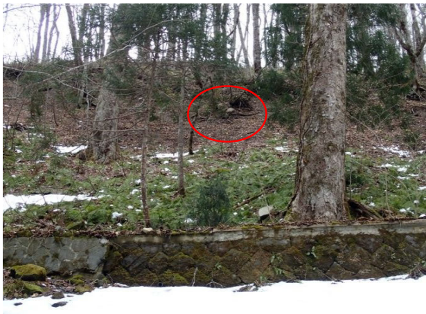
36.20kp付近:斜面 新たな浮石が見られる。
