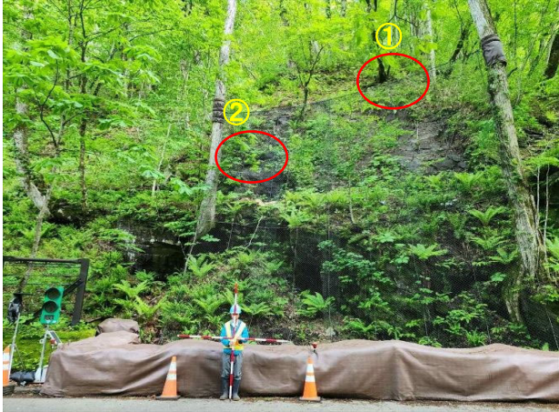
36.11～36.14kp付近(上り線) (1/4) 道路から直高13m付近に不安定な転石が認められる。大型土のうとネットで応急対応している。
