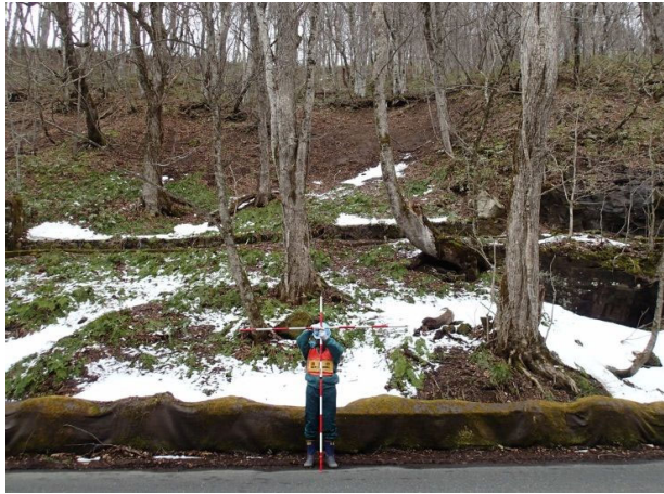
(1/2)36.15kp付近: 斜面状況 (H19.9の豪雨時に崩壊し、道路路肩まで土砂が流出した箇所)
