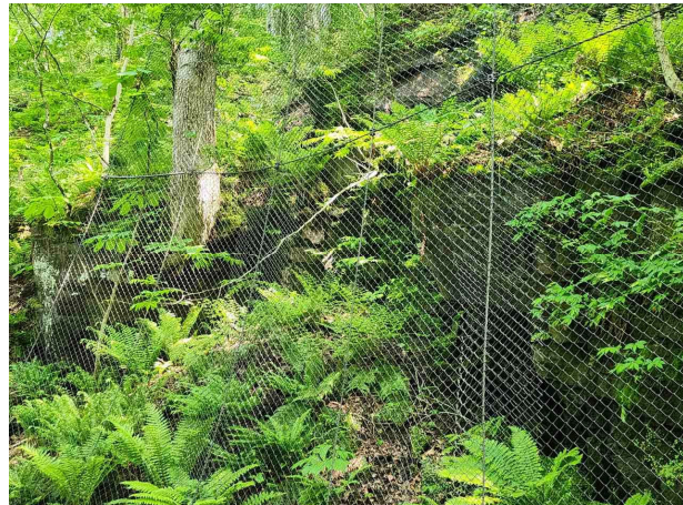
36.11～36.14kp付近(上り線) (4/4) : (1/4)②の拡大 直高13m、奥行き26mに不安定な転石(φ30～50cm位)が視られる。ネットで応急対策している。
