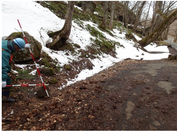
36.22Kp付近 新たに見られた落石(幅30cm、高さ30cm、厚さ20cm)
